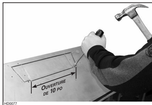
Retrait de l'ouverture préamorcée sur la plaque du ventilateur.
