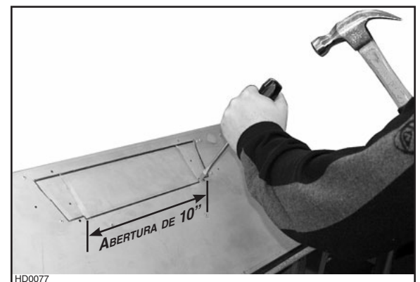
Rompación de la abertura vertical en la placa del ventilador.
